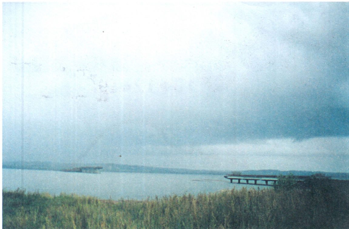
Строящийся мост через Обвинское «море» в районе пос. Ильинского.
